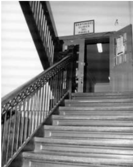
Escaleras que conducen a La Clínica
